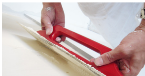
Incollaggio dei pannelli
