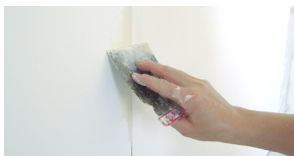
Trattamento dei giunti
